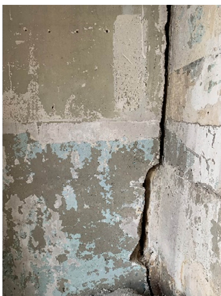
Figure 27: aperçu du désaffleurement du mur
