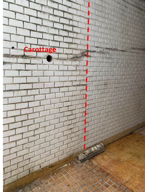
Figure 22: Aperçu de l'emplacement du carottage sur la zone M-04 et de la limite de zone
