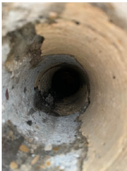
Figure 19 : aperçu de l'homogénéité de la maçonnerie à l'intérieur du carottage
