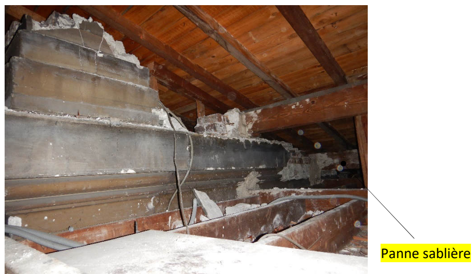
Figure 37 : aperçu de la charpente au niveau de la zone TC-01
