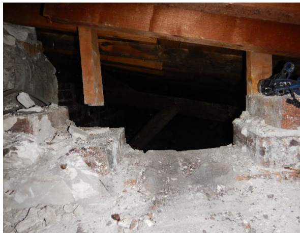
Figure 33: trappe réalisée pour atteindre la charpente de la zone TC-01
