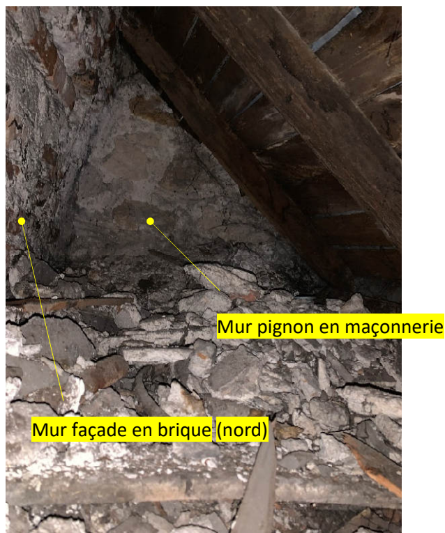
Figure 39: Aperçu de la charpente au niveau de la zone TC-02 (Vue vers l'est)
