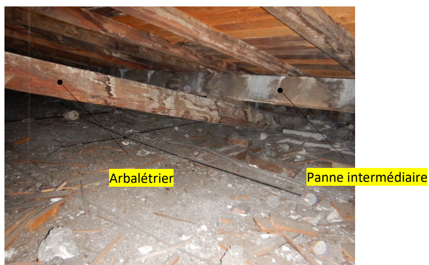
Figure 36 : aperçu de la charpente au niveau de la zone TC-01
